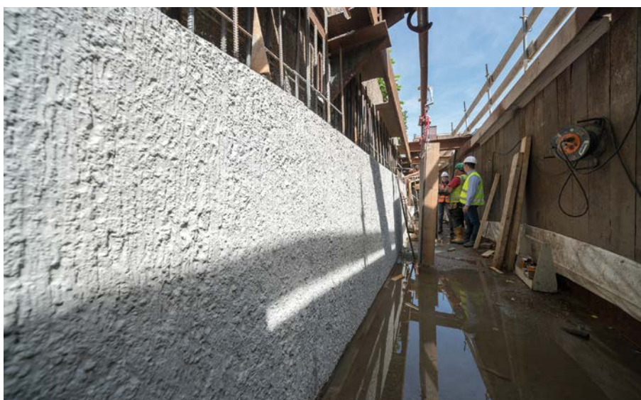
De structuur van de Krakau-matten geeft de oevermuren een ruw, onregelmatig en oneffen oppervlak waardoor mossen en ander groen goed de gelegenheid hebben om zich op het beton te nestelen. (Foto's: NOE-Bekistingstechniek)
